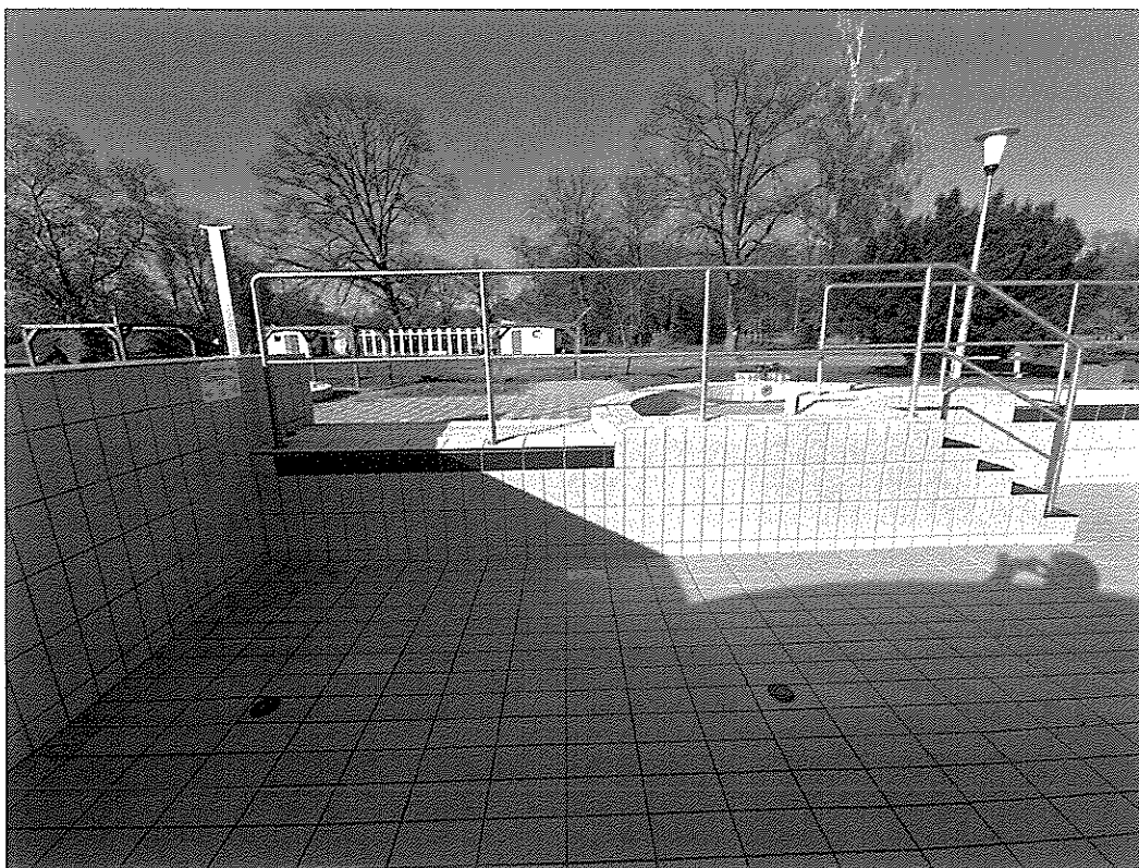
39. kép - tanmedence északi fal, repedések nem láthatók
