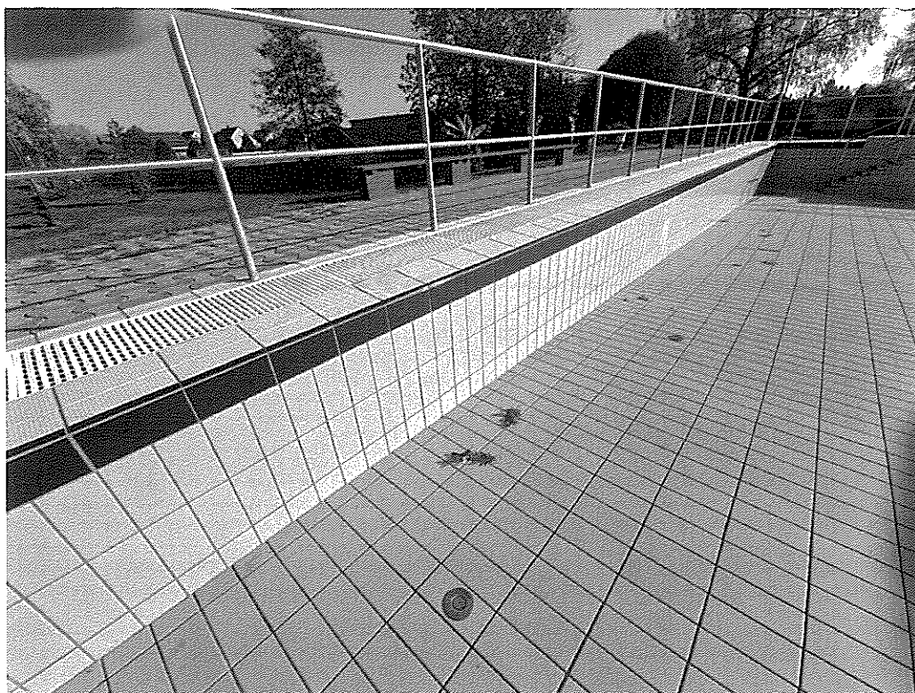
40. kép - tanmedence keleti fal, repedések nem láthatók
