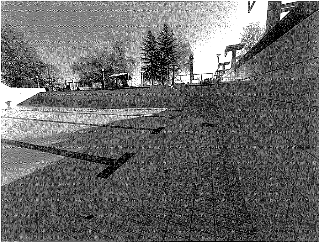
29. kép - úszómedence déli és nyugati fala, repedések nem láthatók
