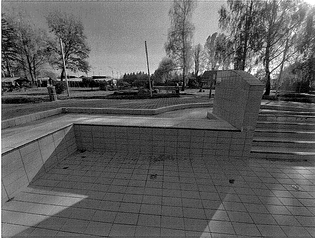
7. kép - gyerekmedence déli fala, a lépcsőtől keletre, repedések nem láthatók
