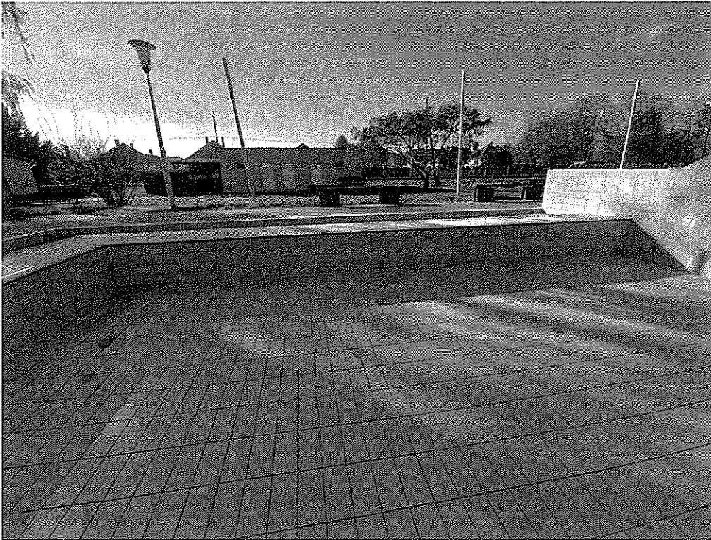
5. kép - gyerekmedence nyugati fala, repedések nem láthatók
