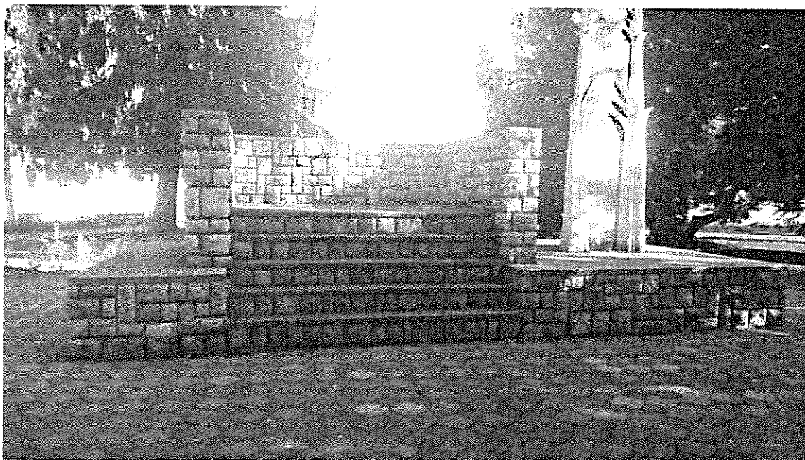
A tribünként is szolgáló építmény hátsó oldala a lépcsőkkel
